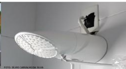
Vedação em saída elétrica de chuveiro
